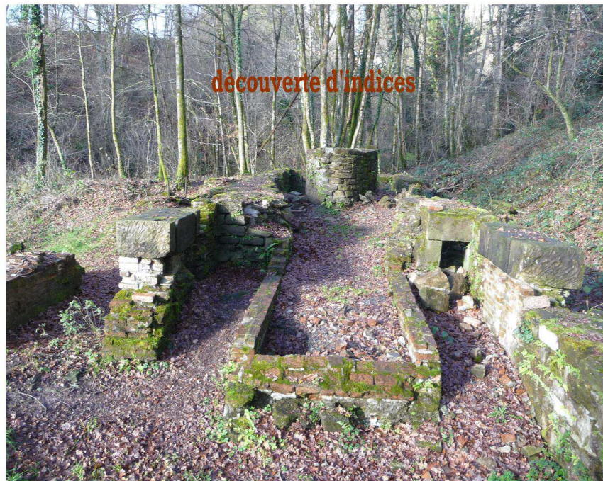
Ruine d'un ancien bâtiment du puits Sainte-Marie de la seconde moitié du XIXe siècle.
